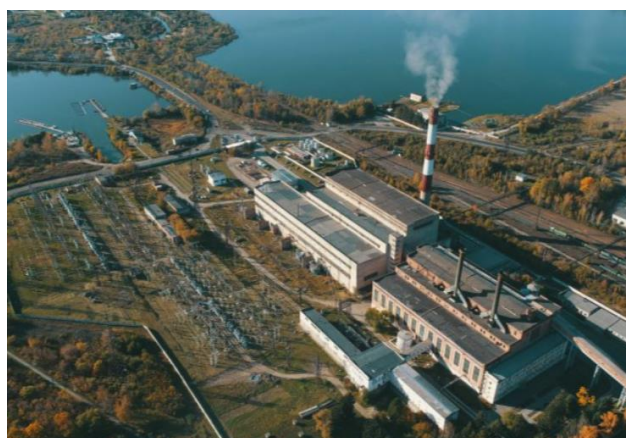
Райчихинская ГРЭС Вывод 86,0 МВт Строительство газовой котельной 3,0 млрд. руб.
